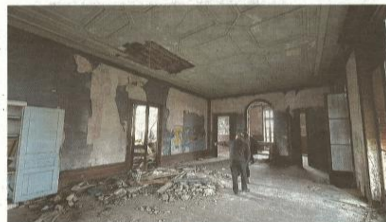
Au premier étage, toutes les cloisons ont été cassées. On y trouve désormais le salon, les salles à manger, la cuisine ouverte. Chaque fenêtre fournit une vue imprenable sur les vignes.
